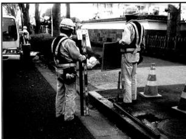
埋め込み長の確認
